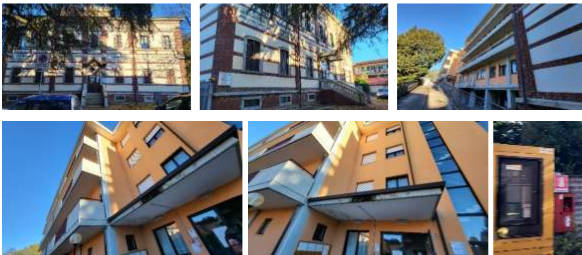
VISTA ESTERNA RSA/CASA DELLA COMUNITA'
